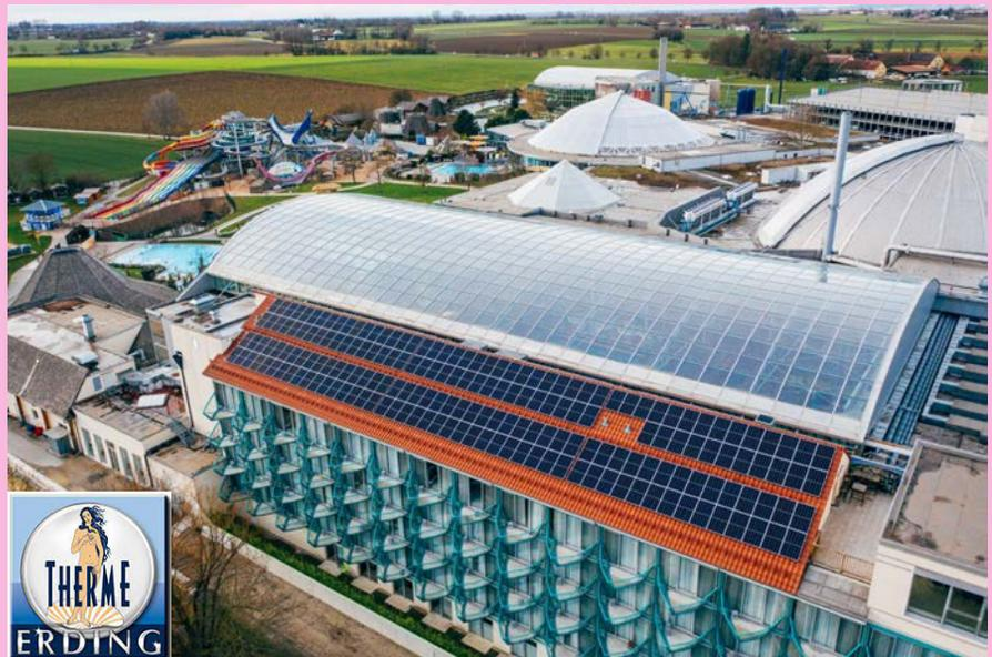
Regenerative Energie spielt in der größten Therme der Welt bereits von Anfang an eine wichtige Rolle. Dank der fünf zu öffnenden Glasdächer wird jeder Sonnenstrahl genutzt und dadurch Heiz- und Lüftungsenergie gespart. Die geothermische Nutzung des 65°C warmen Heilwassers verringert den CO<sub>2</sub>-Verbrauch ebenfalls seit 1999 maßgeblich. Das
